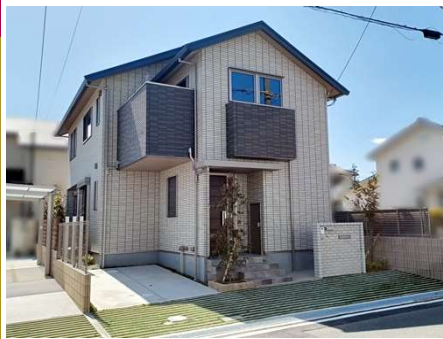
太陽光発電(3.88kW)、エネファーム
