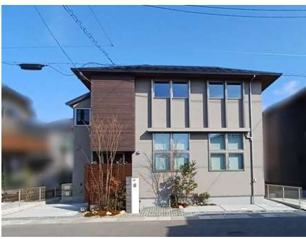
太陽光発電(4.48kW)、オール電化住宅
