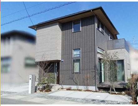
太陽光発電(4.56kW)、オール電化住宅
