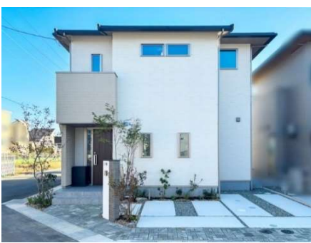
太陽光発電(3.48kW)、オール電化住宅
